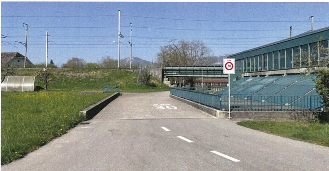
Abb. 20: Bestehende Signalisation und Bodenmarkierung am Aareweg
